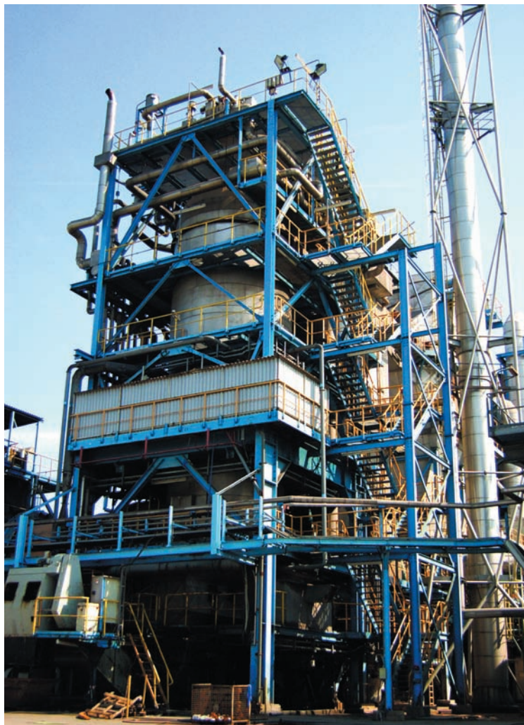
Widok ogólny instalacji SARPI Dąbrowa Górnica
